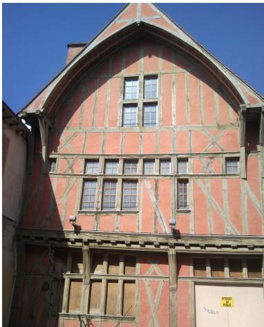
L'intérêt de cette technique est de permettre la construction rapide de bâtiments de plusieurs niveaux à un coût moindre que les bâtiments en pierres de taille. Les matériaux nécessaires étaient disponibles localement : bois pour l'ossature, mortier à base de terre ou un assemblage de briques de terre cuites pour le remplissage et pierres pour le soubassement.
